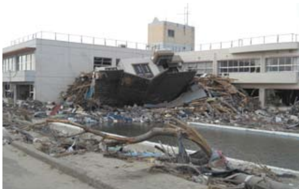
■津波被害を受けた仙台市立中野小学校
